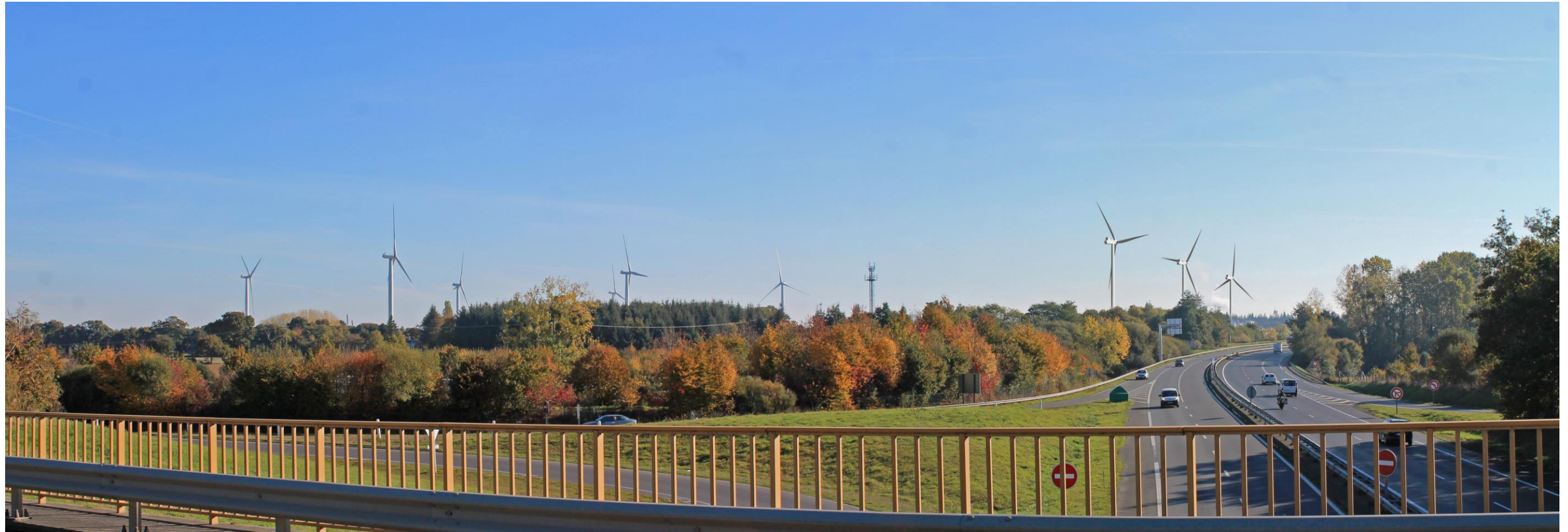
Site éolien de Plestan II Côtes-d'Armor (22)
